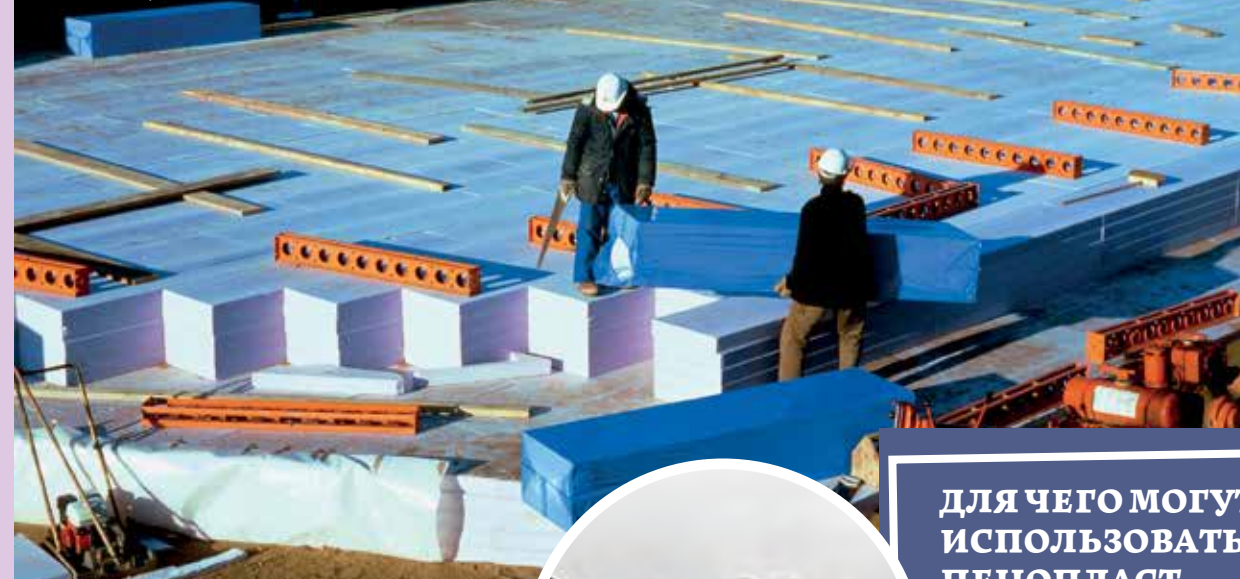
Основной задачей пенополистирольного слоя является защита грунта от перепадов температур, которые могут вызвать нежелательные деформации
