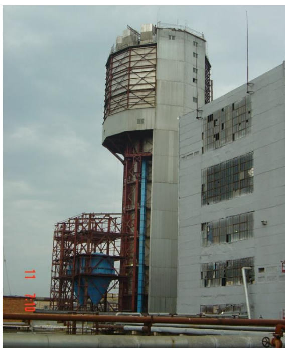
Рисунок 8.14 – Башня прилливания с металлическим стволом
