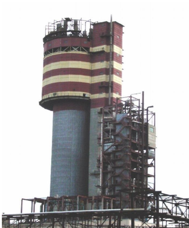
Рисунок 8.13 – Башня прилливания с железобетонным стволом
