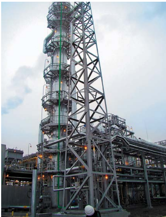
Колонное оборудование установки НТК-2 на Губкинском ГПК
