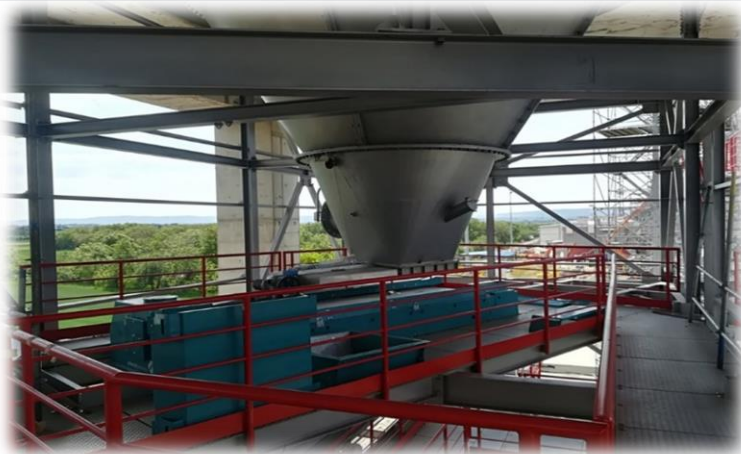
Монтаж стальной конструкции и трубопровода в зоне коксовой ямы
