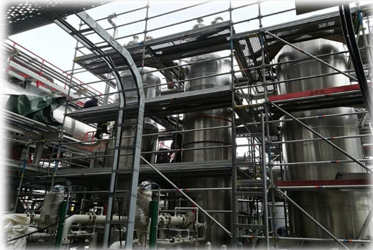
Монтаж стальной конструкции и трубопровода в зоне коксовой ямы
