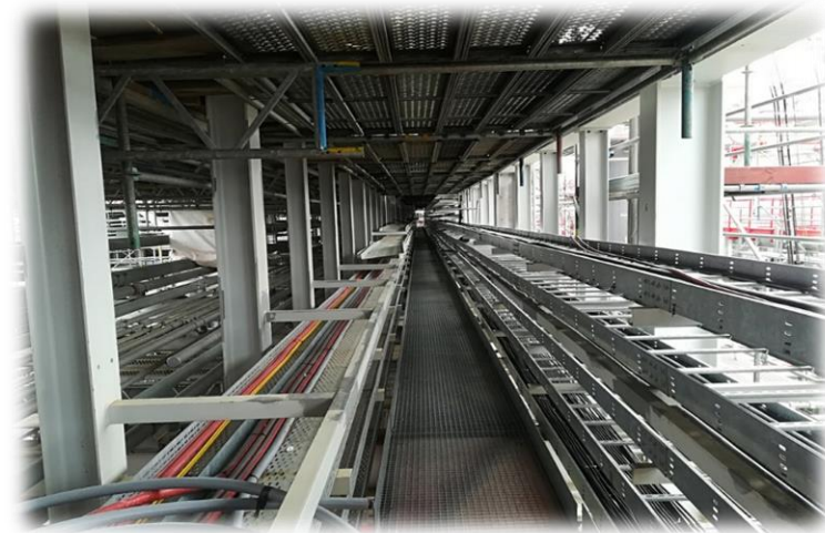
Прокладка кабелей на трубной эстакаде
