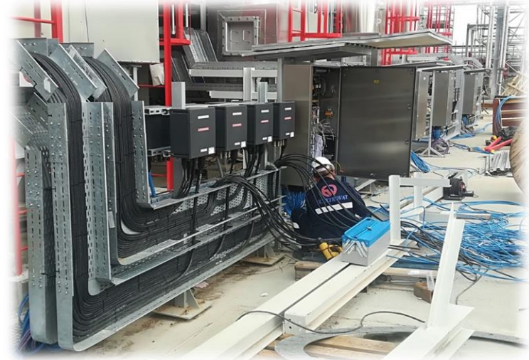
Прокладка кабелей на трубной эстакаде
